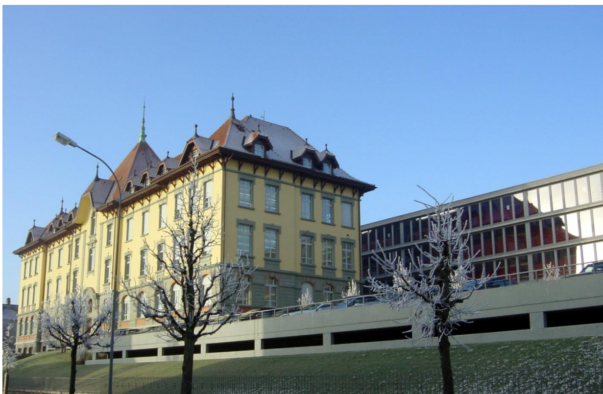
L'ECGF vue depuis l'Avenue du Moléson : Bâtiment A à gauche et Bâtiment B à droite.
